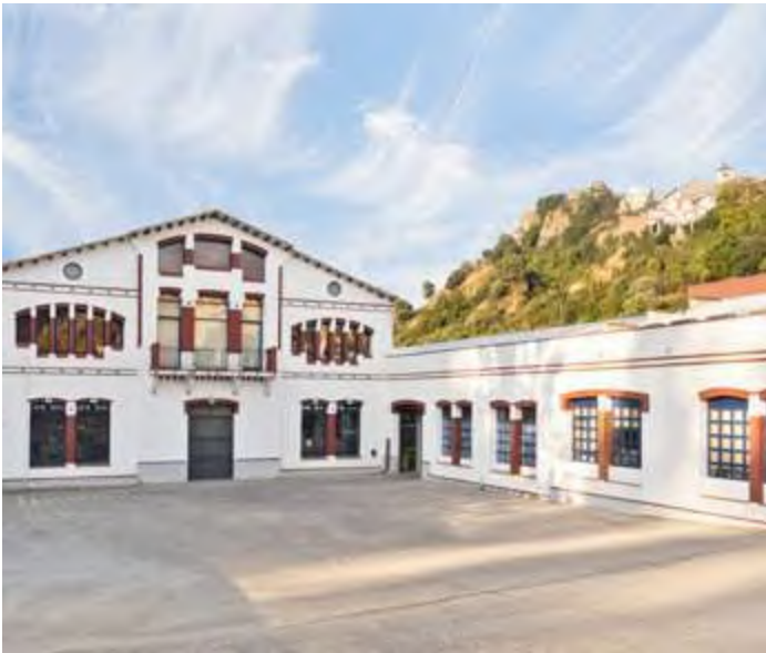
Weaving plant. Santa Maria d'Olió, Barcelona.
